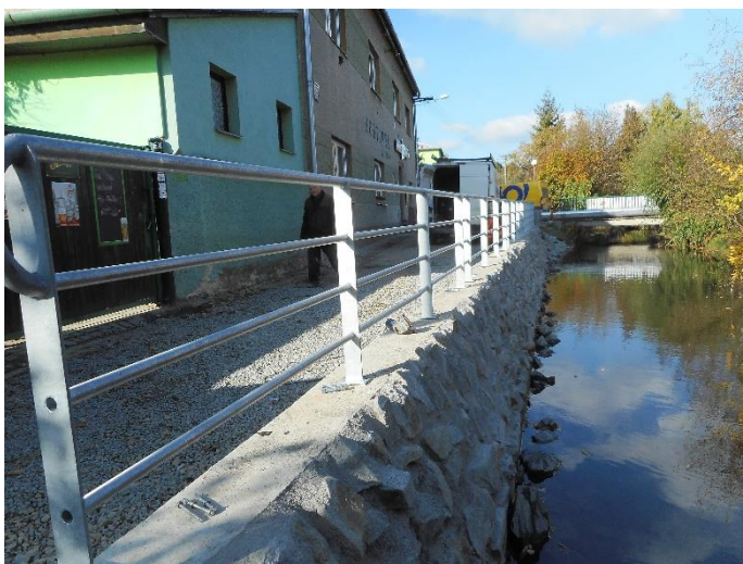
Výstavba opěrné zdi ujíždějího břehu mlýnského náhonu před plánovanou stavbou komunikace Malý Jílkov
